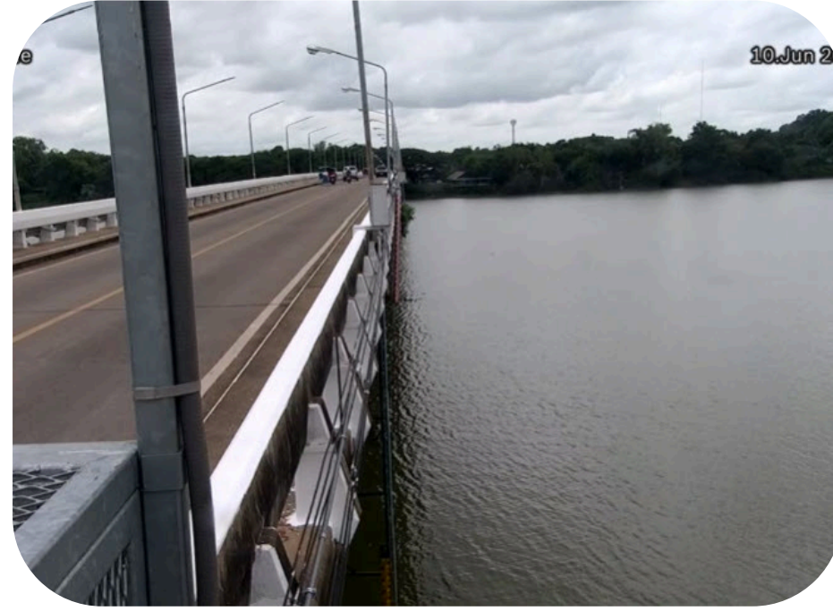
ระดับน้ำปัจจุบัน 106.73 ม.รทก. เกณฑ์วิกฤติ 111.50 ม.รทก.
